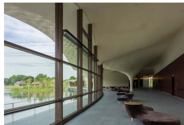
アルタスウッドスクリーンの施工例
