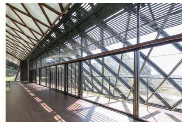
木・アルミ複合断熱建具 「ワイドネスウインドウ」の施工例
