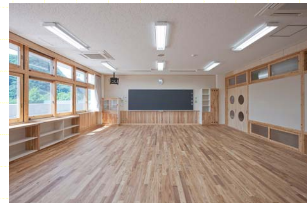
木・アルミ複合窓 「アルタスウッドウインドウ」の施工例
