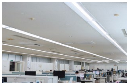
照明設備のLED化
