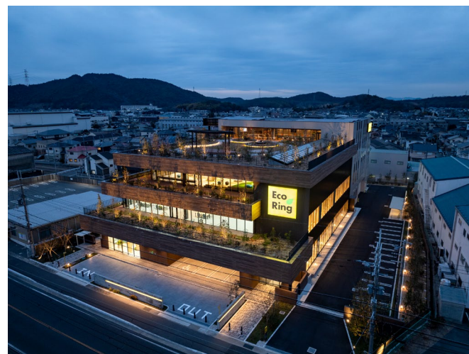
木・アルミ複合断熱建具の施工例
