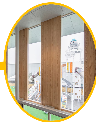
上段のCLTが日除けとなる
