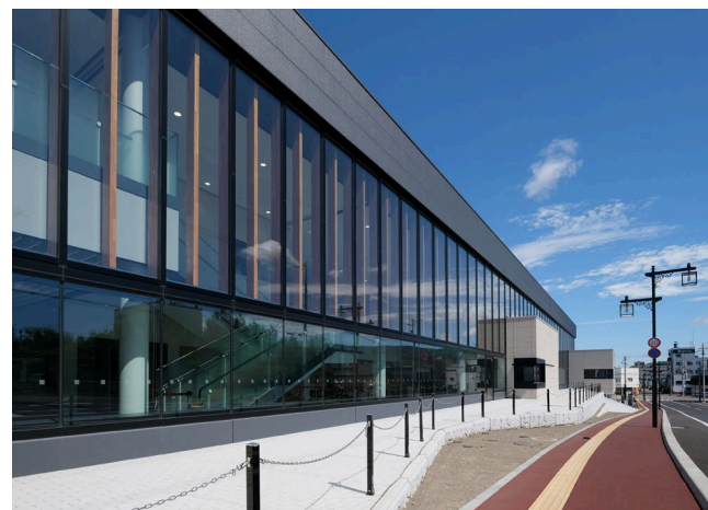
アルタスウッドスクリーンの施工例
