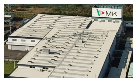
断熱性塗料を塗った工場屋根
